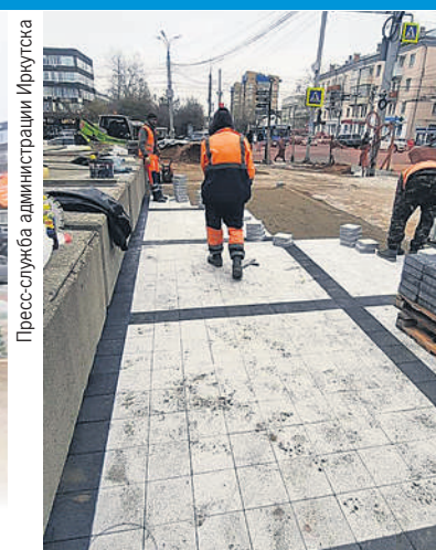
Рабочие должны завершить укладку тротуарной плитки в октябре.
