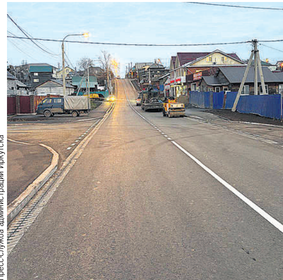
При необходимости подрядчики устраняют замечания.
