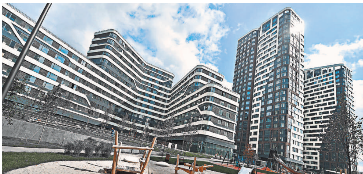
На территории бывшего металлургического завода «Серп и Молот» в Рогожской слободе введены 300 тыс. кв. м жилья и гаражный комплекс.
